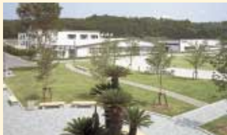
オムロン熊本の外観
