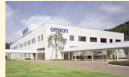
オムロン武雄の外観
